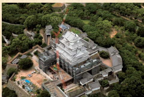
姫路城 平成の大修理工事(平成27年)
