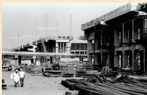
山陽新幹線高架橋工事(昭和45年)
