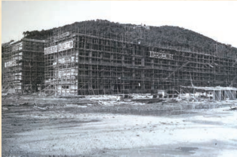
市立姫路高等学校新築工事(昭和45年)
