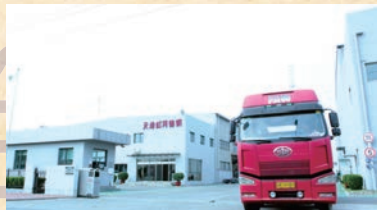
天津虹岡鑄鋼有限公司(中国天津市)
