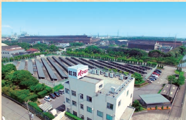
本社と姫路東工場全景
