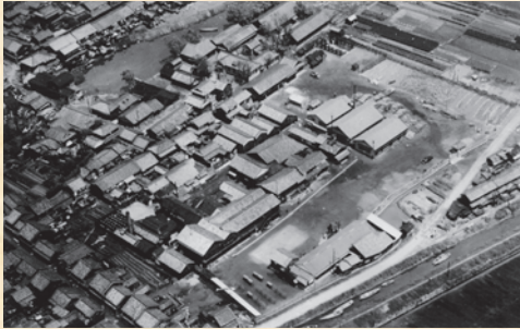
大和嶺寸株式会社 本社工場
