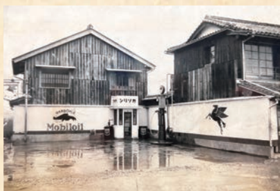
昭和4年 飾磨給油所
