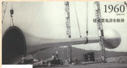
巨大な給水塔の据付工事
