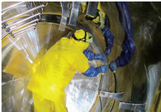
タンク内面電解研磨作業の様子
