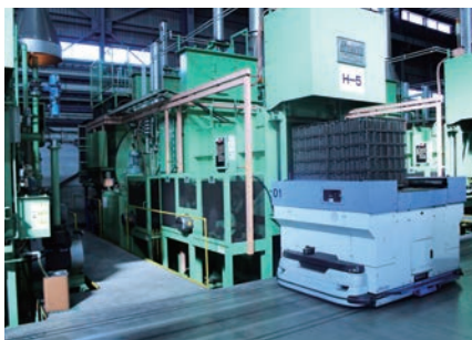
第二工場のガス浸炭焼入れ炉 手前では、自動搬送台車が炉から荷受けしている
