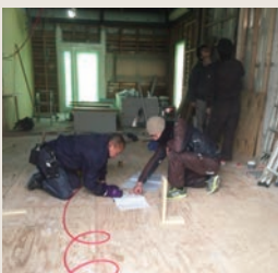
協力業者さんとの 現場打ち合わせの様子
