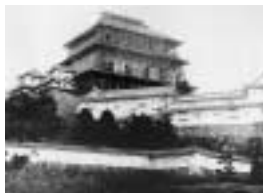
改修中の天守閣
