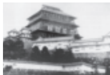
改修中の天守閣
