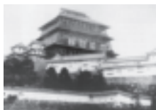
改修中の天守閣
